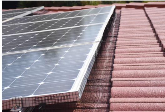
3. Ábra: Napelem panel madárcsapásoktól való megóvására egy lehetséges megoldás, ahol a napelem alumínium keretére erősített drótszerű anyaggal körbekerítik a napelemet, ezzel meggátolva, hogy madarak (pl.: galamb) rakjon fészket a napelem alá [forrás: https://www.easypestsupplies.com.au/solar-panel-bird-mesh-kit ].
