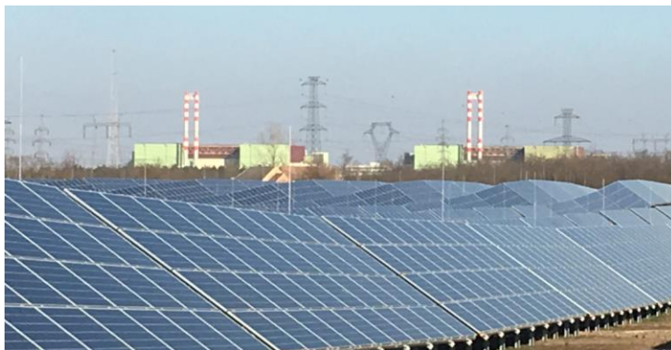
8. ábra A Paksi Atomerőmű és a 20,6 MW-os naperőmű Forrás: saját fotó
