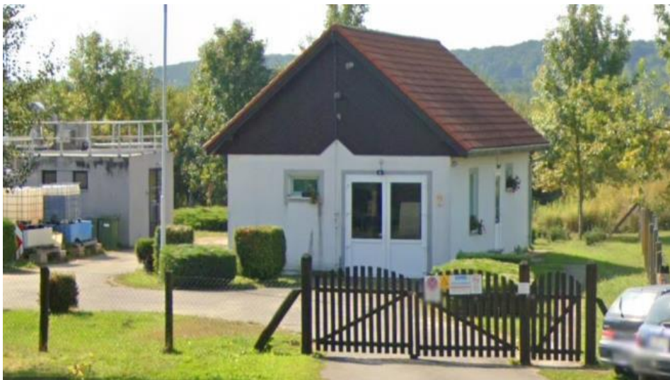
4.számú kép A szennyvíztisztító telep északi szakaszának egy része (forrás: https://earth.google.com/web/@46.7925724,16.41176458,212.45225029a,0d,15y,181.3190533h,85.56393002t,0r/data=!hoK-FIFLTUc2X1BZNmk3SzdHbGpIVzY2SWcOAg )
