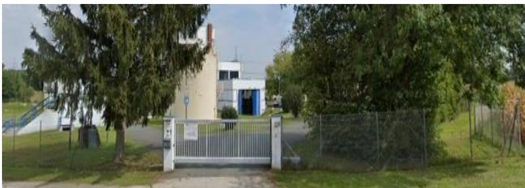
3.számú kép A fentnevezett szennyvíztisztító telep északi és nyugati kerítés szakasza (forrás: https://www.google.com/maps/@47.2535197,16.2766551,3a,90y,96.08h,106.78t/data=!3m6!1e1!3m4!1sGeuB2HCCcR-28J2dJ-bHDQ!2e0!7i16384!8i8192?hl=hu )
