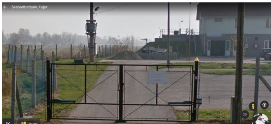
7.számú kép A szennyvíztisztító telep bejárat és a keleti kerítés szakaszának egy része (forrás: https://earth.google.com/web/search/Szabadbatty%C3%A1n/@47.11949087,18.38336751,101.19302697a,0d,21.86874171y,136.11371527h,86.71579074t,0r/data=CigiJgokCbOLWjcTskdAEdYNTTOWjkdAGYQ_Opns_iJAIT7q3KDPJzJA )
