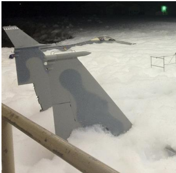
3.sz kép: Repülőgép hangár elárasztása könnyűhabbal [13]
