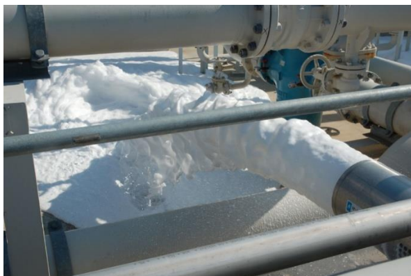
2.sz kép: Középhab habfolyató alkalmazása technológiai védelemre [10]
