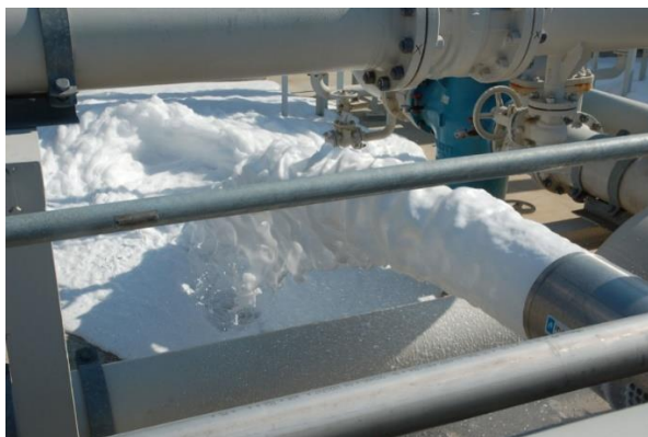
2.sz kép: Középhab habfolyató alkalmazása technológiai védelemre [10]
