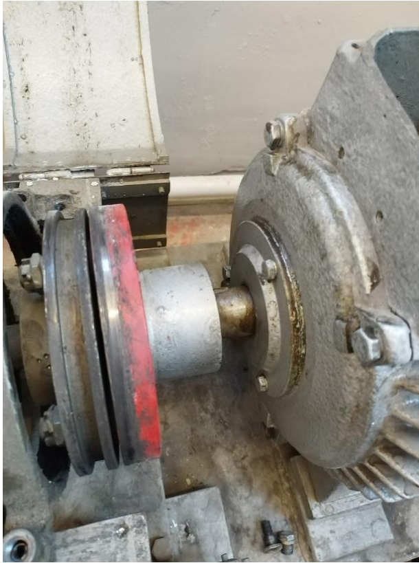
4. ábra Csúszógyűrűs aszinkron motor tengelykapcsolat burkolat eltávolítása.
