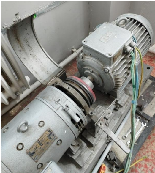
5. ábra Csúszógyűrűs aszinkron motor tengelykapcsolatának ellenőrzése.
