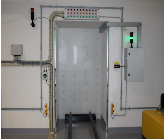
11. ábra: A végleges kialakítású anyagforgalmi ajtó, összesen 9,5 cm ólomegyenértékkel [saját szerkesztés]
